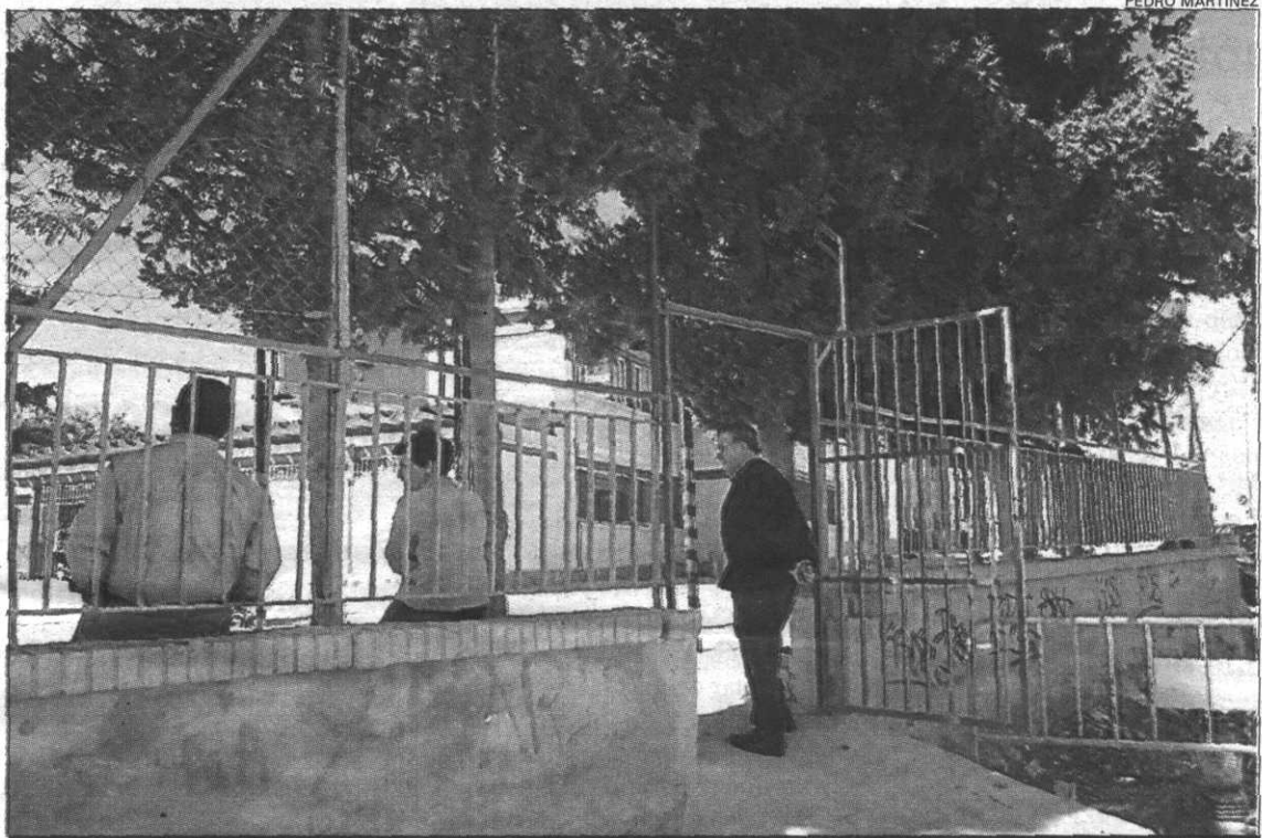
Vallas rotas en una puerta de entrada al colegio Contraparada de Javalía Nuevo que se beneficiará de las obras
